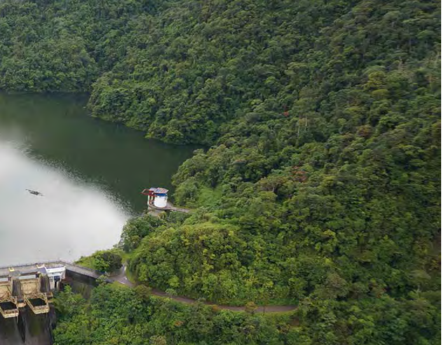
Central Hidroeléctrica Anchicayá, Valle del Cauca.
