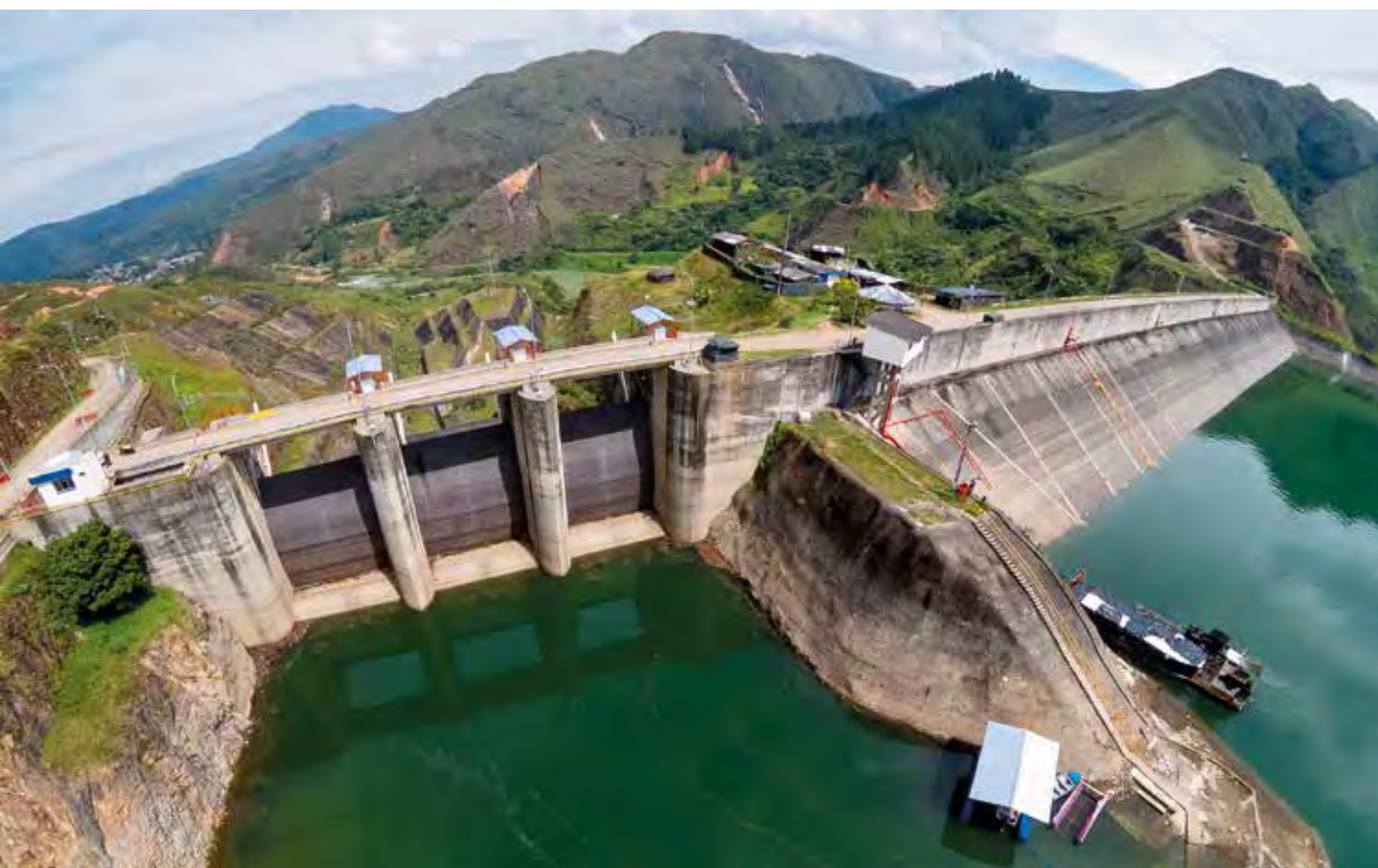
Central Hidroeléctrica Salvajina, Cauca.
